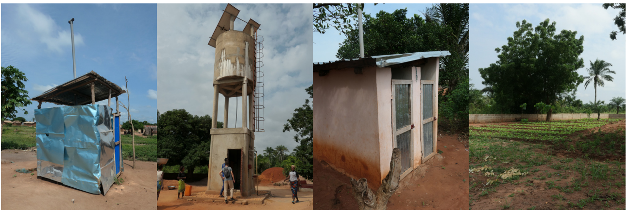
Quelques réalisations d'Enfants des Collines et d'Humanité Plus: de gauche à droite, latrine économique, château d'eau, latrines collectives et jardin potager éducatif.
